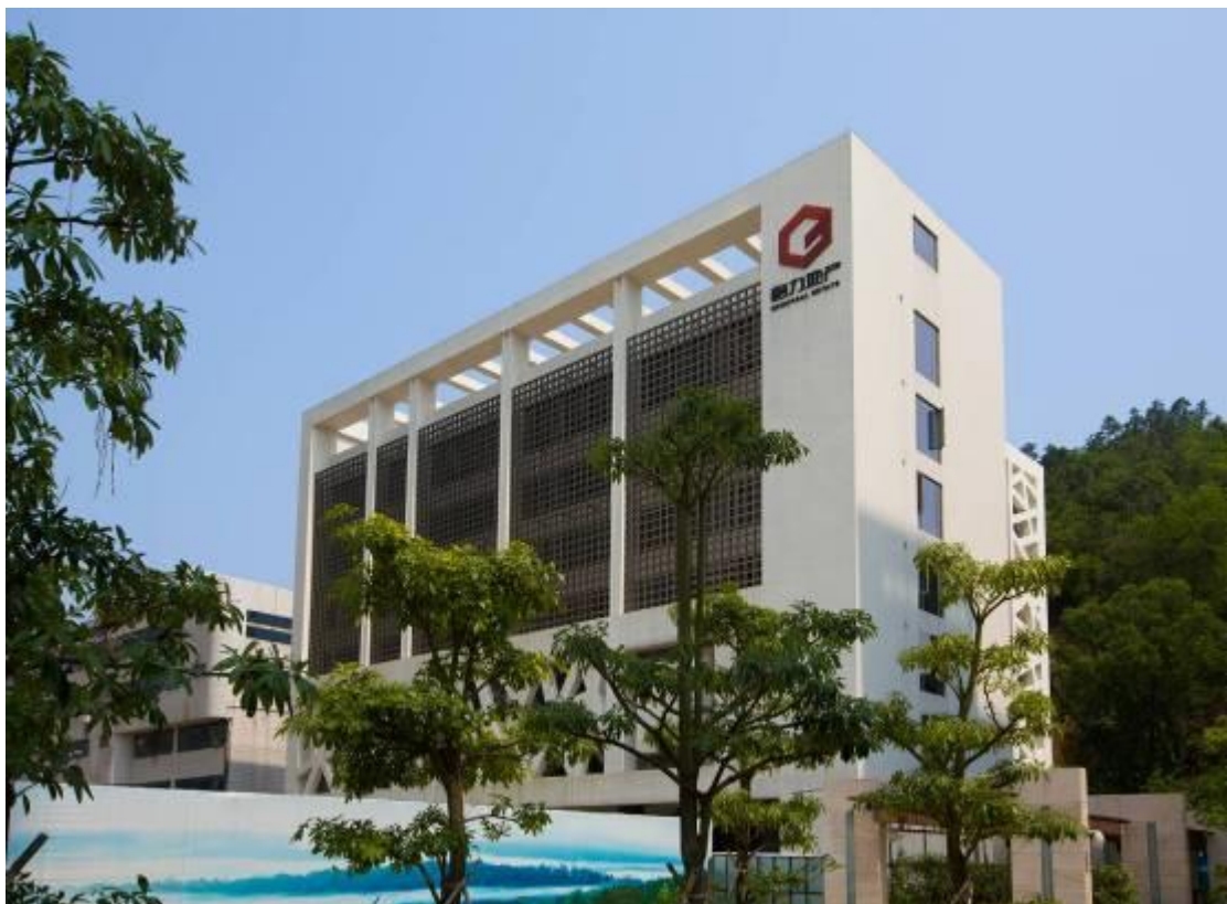
格力地产办公楼
