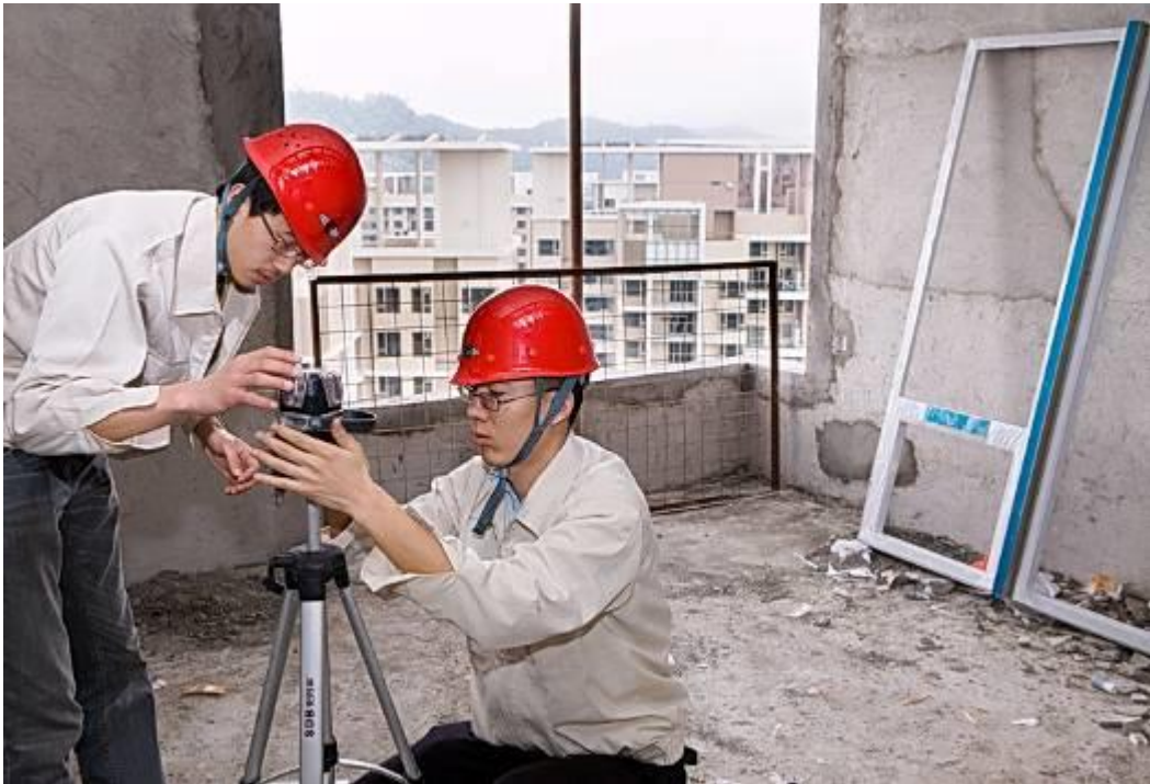
工作人员对项目施工进行精细测量
