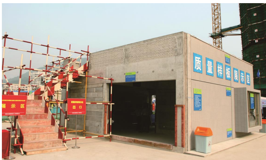
质量样板示范区
