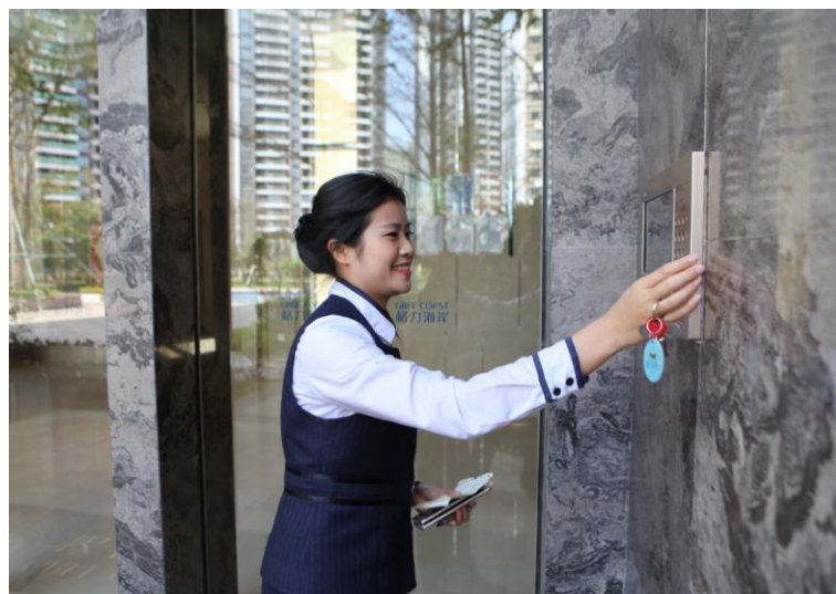
楼栋管家检查可视对讲系统
