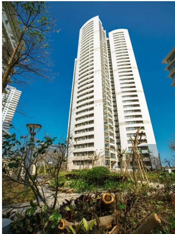
“天鸽”过境后，格力海岸门窗玻璃一块未碎
